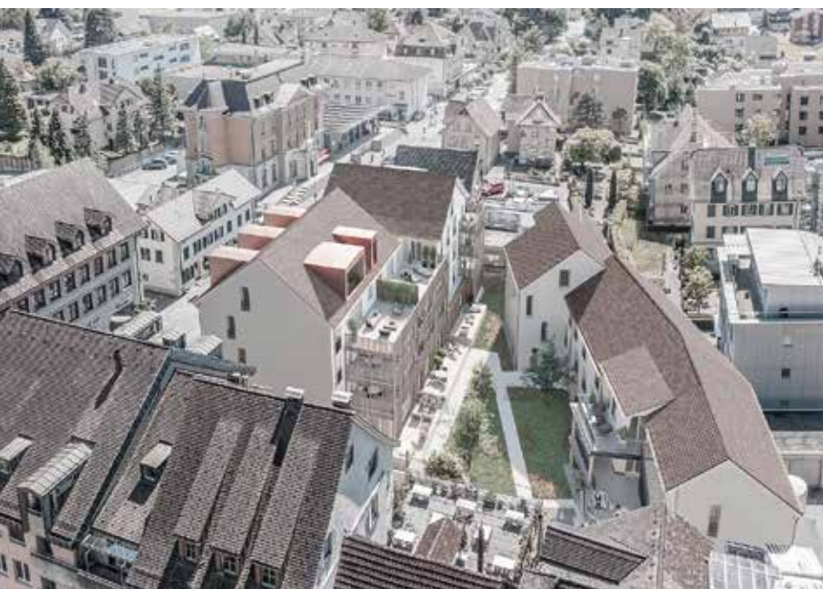
Beim «Plätzli» werden die verschiedenen Energiesysteme optimal vernetzt.
